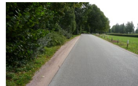
Bewust aanbrengen van passeerstroken om beschadiging van berm en hagen te voorkomen
