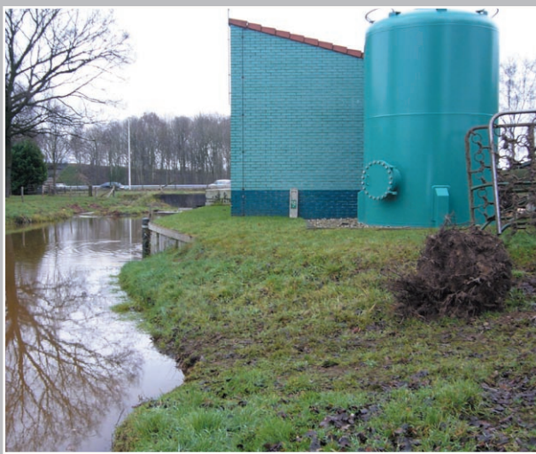
Infiltratieproject Epe: Waterschap Veluwe en Vitens onttrekken hier water en pompen het naar infiltratieplassen. Na bezinking wordt het als drinkwater gebruikt.
