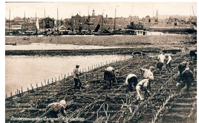
foto boven: werken aan de Afsluitdijk onder: Zuiderzeewerken bij Lemmer
